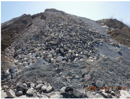
熊谷川の土砂崩落の様子
