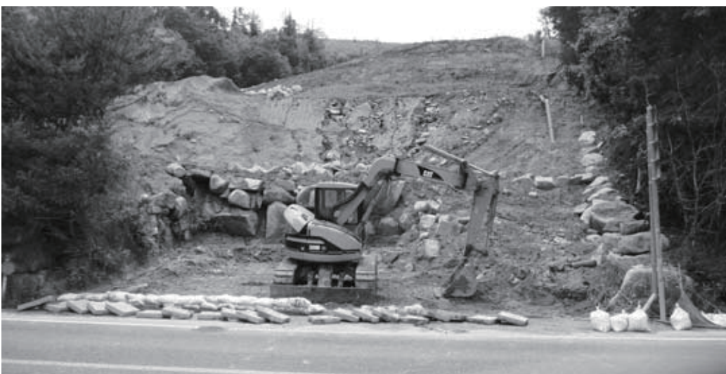
三和残土処分場
