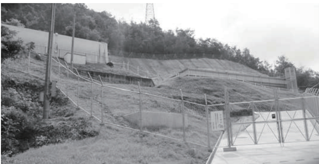
矢原配水池 第2配水池
